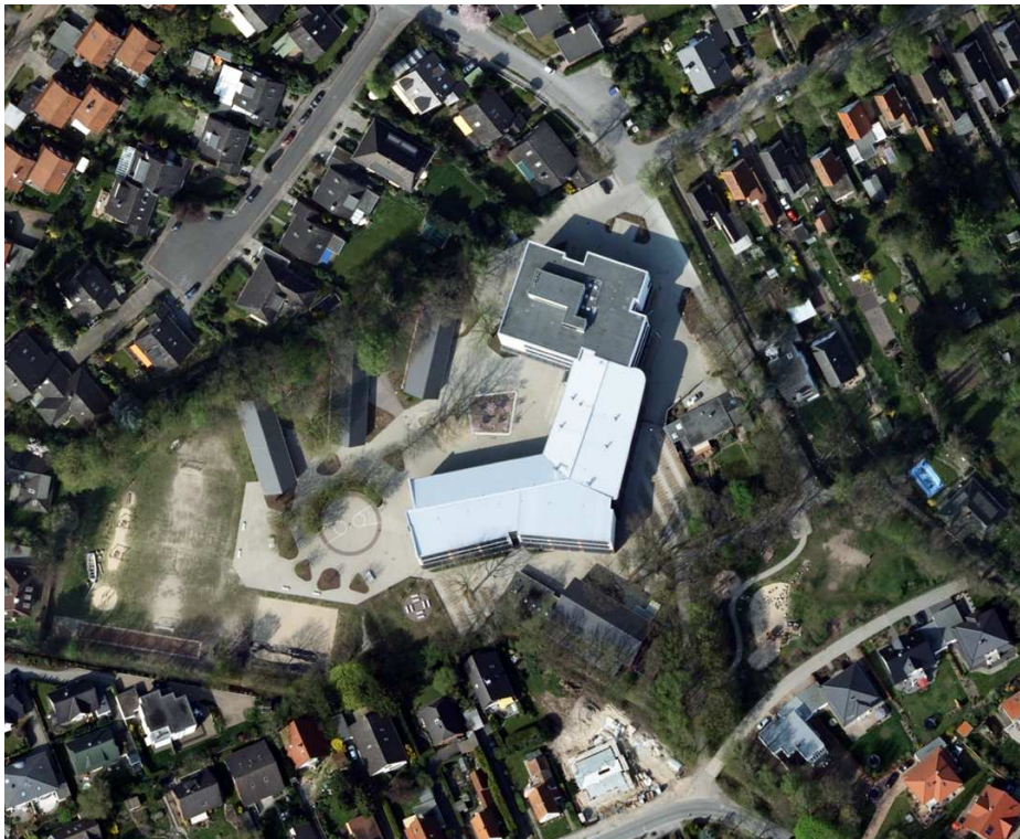
Luftbild. Der südlich angefügte Neubau ist durch das helle Metaldach erkennbar
