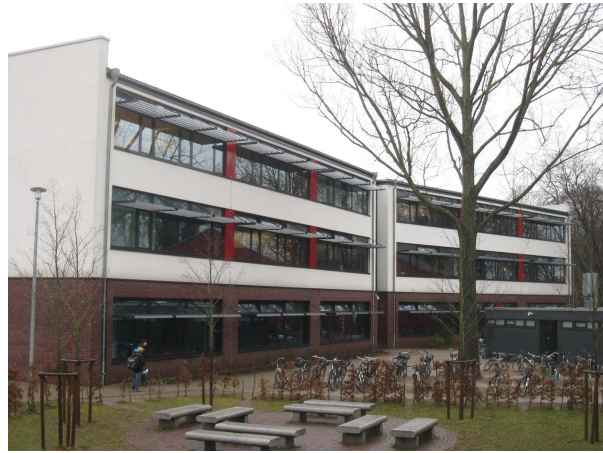
Ansicht Neubau, von SW
