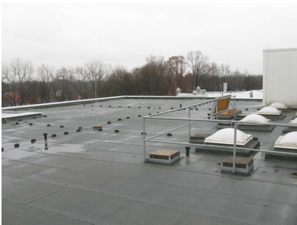
Dachansicht Altbau, von N
