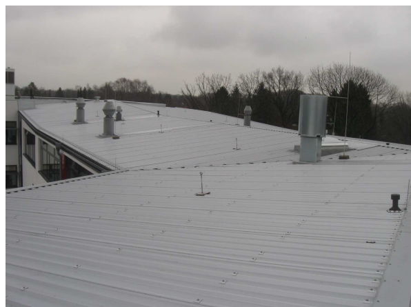
Dachansicht Neubau, von SW
