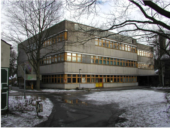
Ansicht Altbau, von N
